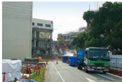
1号棟部分の解体の様子 (2018年10月31日時点)
